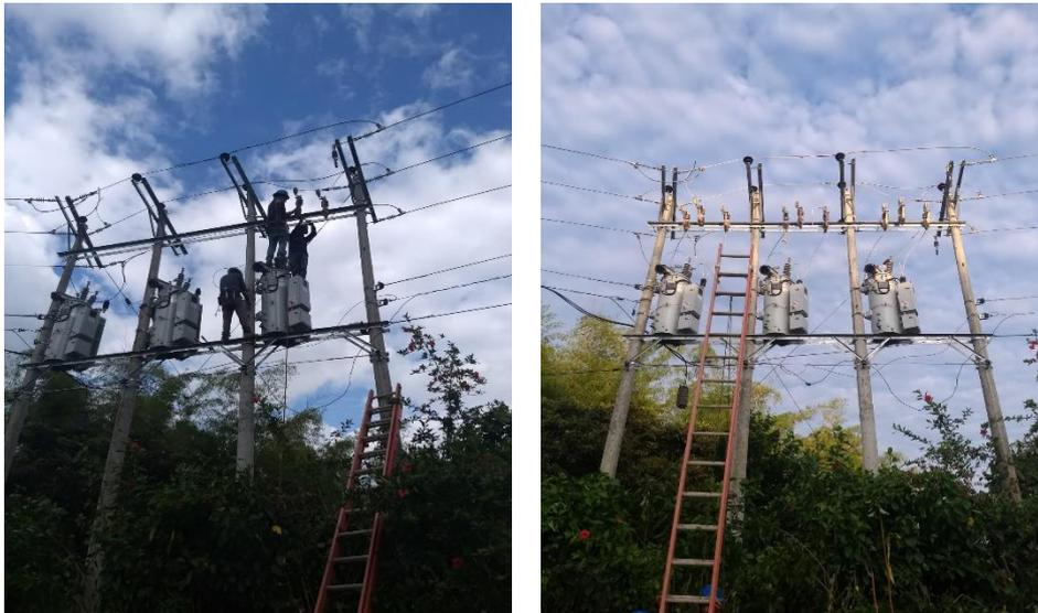
Figura 14. Adecuación Red Eléctrica para Montaje de Reguladores de Voltaje Monofásicos.
